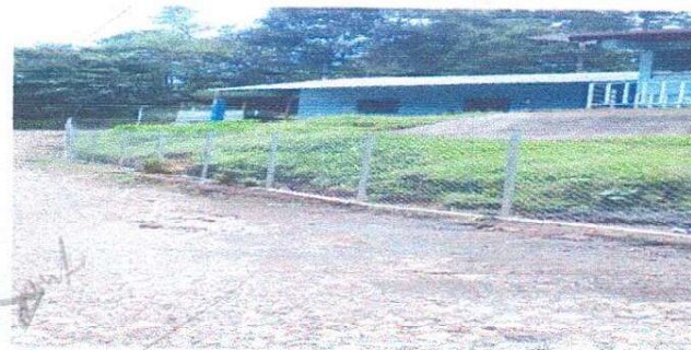
Foto 4: colocación de muro de malla
