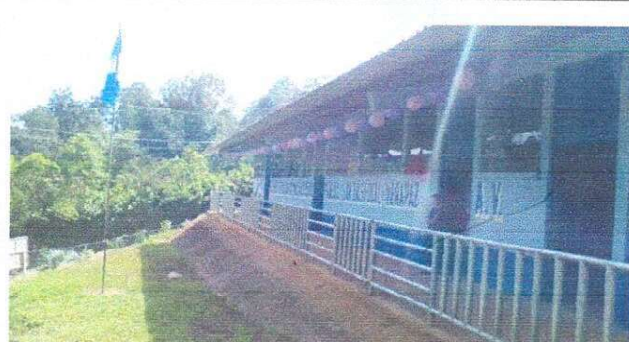
Foto 2: colocación de barda.
