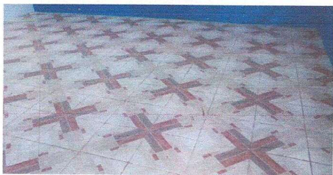
Foto 1: Cubierta de piso en caño
