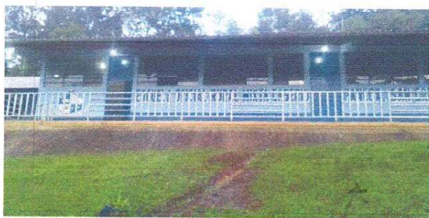
Foto 3: colocación de barda.
